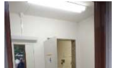
トイレ棟の明るさの改善
