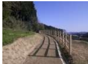
転落防止柵の修繕
