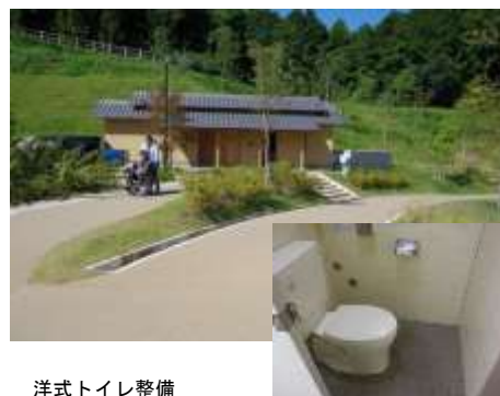
洋式トイレ整備
