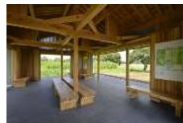
園内の休憩施設
