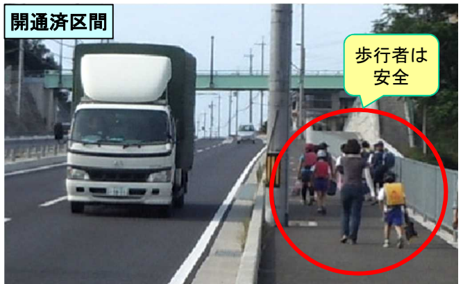
写真②: 4車線完成区間 道路拡幅により歩道を整備(平野小学校付近)
