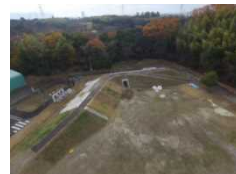
研修用不 具合堤防の全 景
