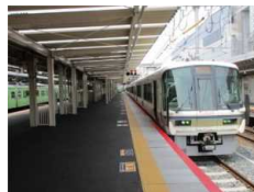
京都駅奈良 線ホーム拡 幅(完成写 真)
