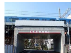
完成後の魚 崎東陸橋函 渠
