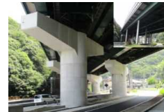
耐震補強工 事 着手前 (右上)と 完成後
