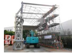
天井板撤去 実証実験設 備
