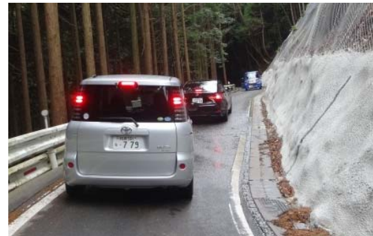
写真① すれ違い困難箇所(幅員5.5m未満)
