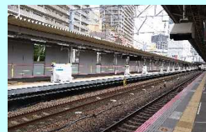
④整備された新型ホームドア
