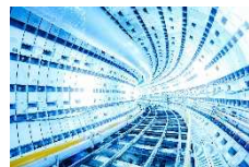
中央北増補幹線 一次覆工の状況（プロカメラマン撮影）
