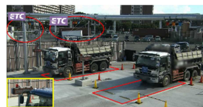
ETC 自動認証中のシールド発生土運搬車両
