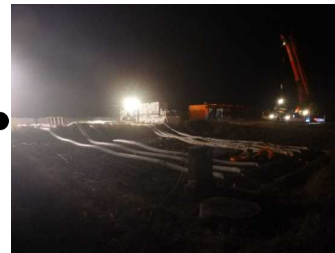
▲第1排水区排水作業中(9/6 0:21)
