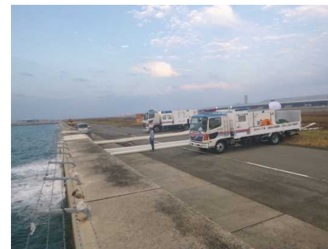
▲第1排水区排水作業中(9/6 5:52)
