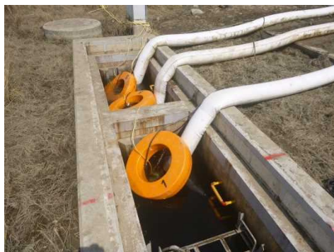
▲第3排水区排水ピット(9/6 13:09)
