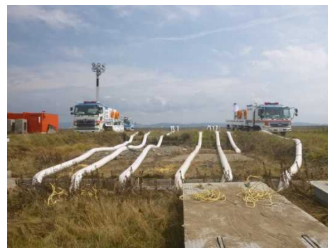
▲第3排水区排水作業中(9/6 13:39)
