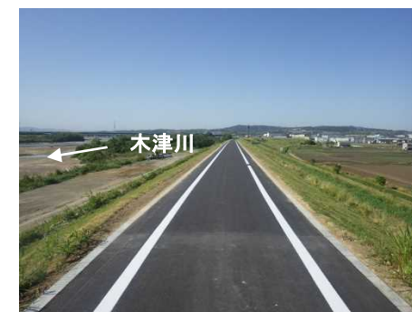
復旧後（令和元年5月撮影）
