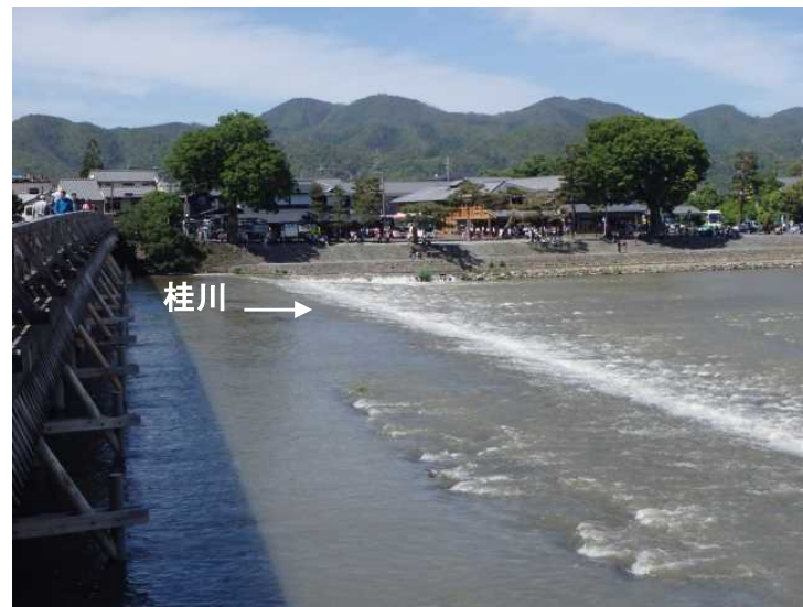
復旧後（令和元年5月撮影）
