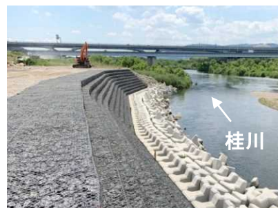
復旧後（令和元年5月撮影）
