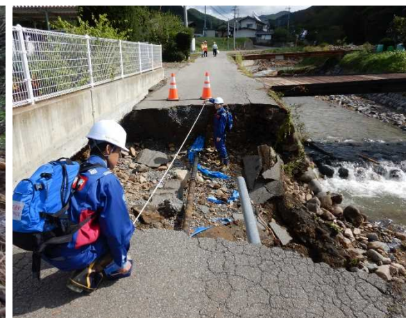
■10/15 道路被害状況調査（長野県佐久市）
