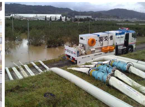
■10/15 排水作業状況（長野市小布施町地先）
