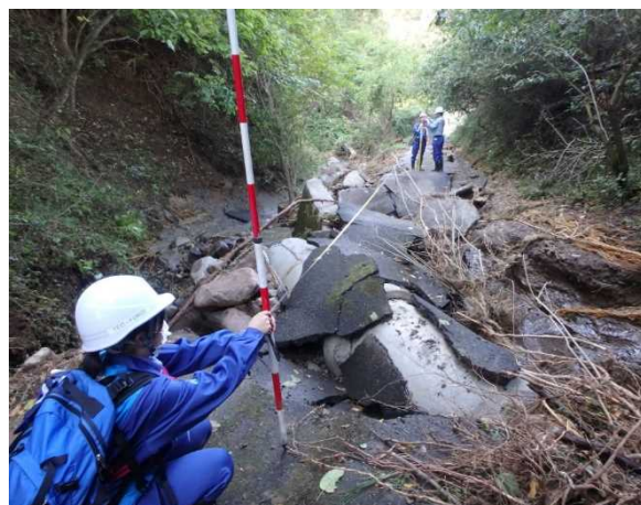
■10/15 道路被害状況調査（長野県小諸市）
