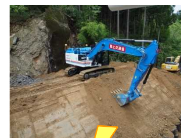
遠隔操縦による施工
