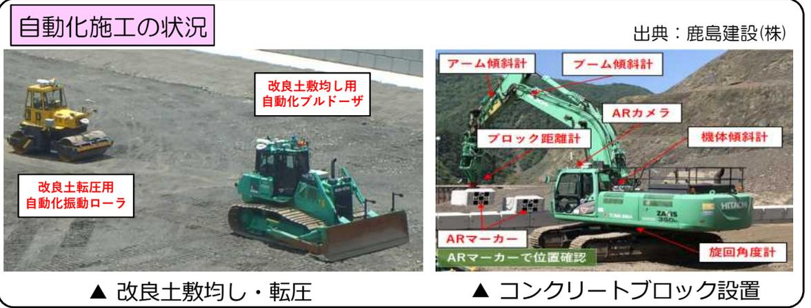
本堰堤の着手にあたっては、設計段階から施工者が関与する技術提案・交渉方式（ECI方式）を採用しています。出水期には人の立ち入りが制限されるこの現場で、施工性を考慮した工法提案を本工事の受注者である鹿島建設株式会社から受けたことにより、自動化施工の実現に至りました。
