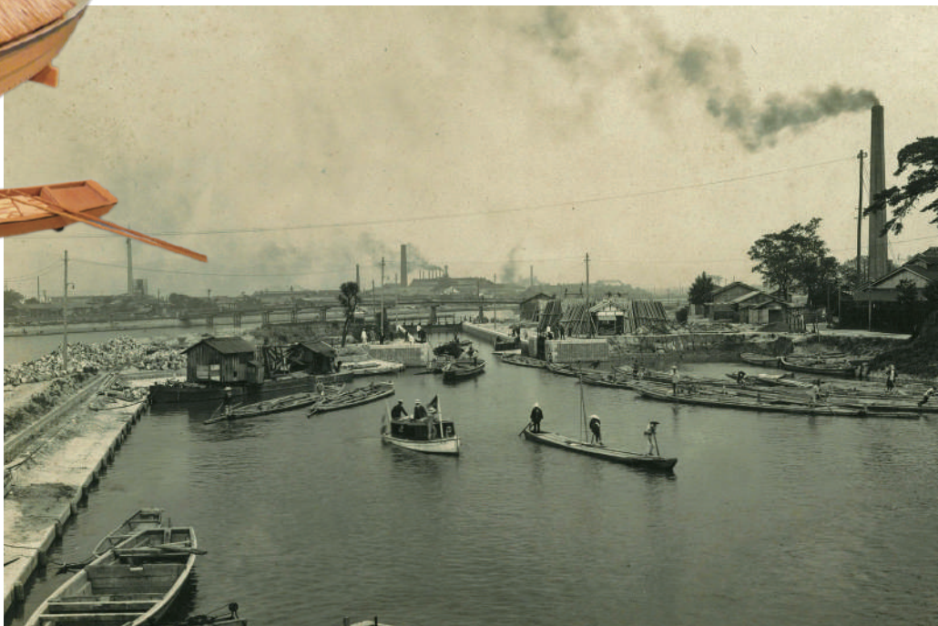
完成した毛馬第二閘門と船溜まり (T7) 都島村毛馬
