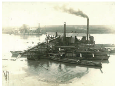
三川合流附換工事 ポンプ式浚渫船(T7~S8) 八幡町
