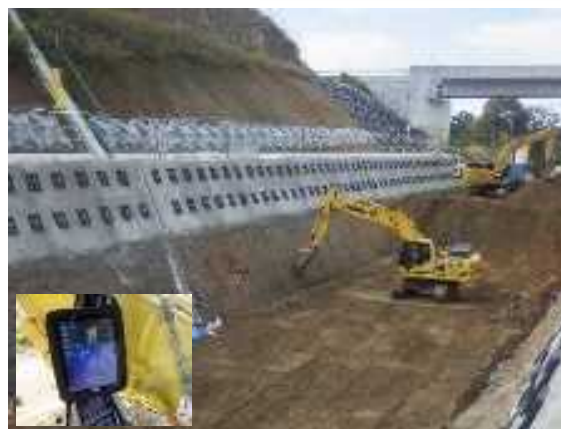
MCバックホウによる施工
