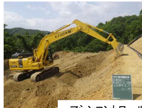
マシンコントロールバックホウによる施工
