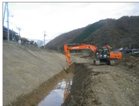
丁張レスによる床掘工
