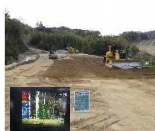
MCブルドーザによる施工
