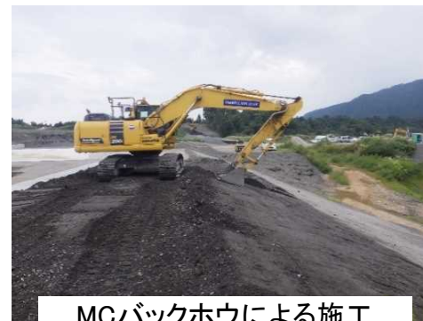
MCバックホウによる施工
