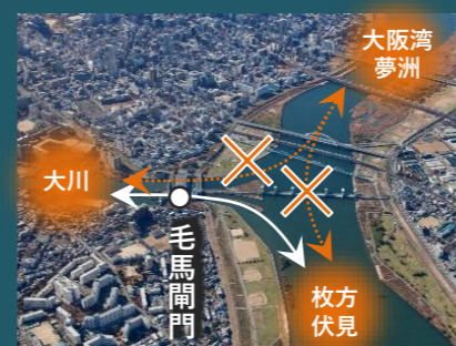
閘門設置前の淀川大堰周辺
