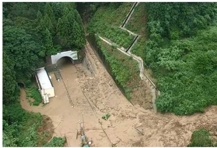
北陸自動車道被災状況
