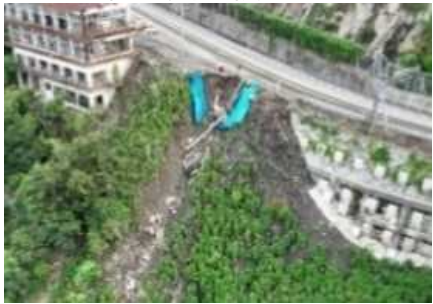
国道8号被災状況
