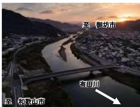
写真①現場の写真(朝日)
