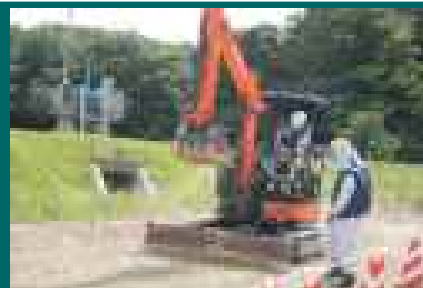
ICT建機実技 (バックホウPATブレードMCによる敷均し)
