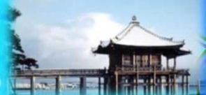
浮御堂(景観対策)
