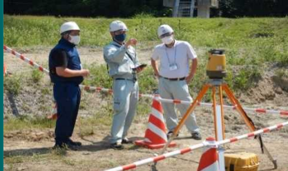
TSを活用した出来形検査の実習
