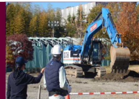
無人化施工機械基本操作体験
