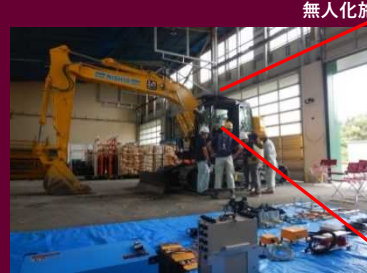
建設機械への簡易遠隔操縦機器の取付実習
