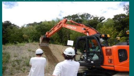
施工データの建機へのセッティングと ICT建機実技 (MCバックホウによる法面整形)
