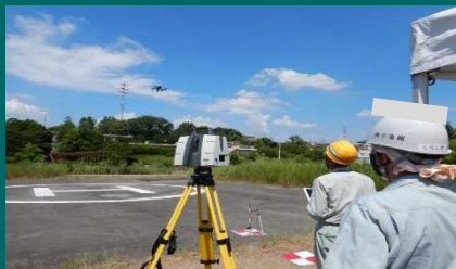
起工測量 (UAV, TLS) の実演
