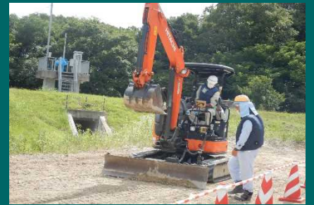
ICT建機実技 (バックホウPATブレードMCによる敷均し)
