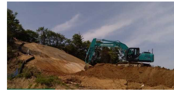
マシンガンバックホウによる施工
