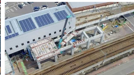
プレキャストスラブ架設状況
