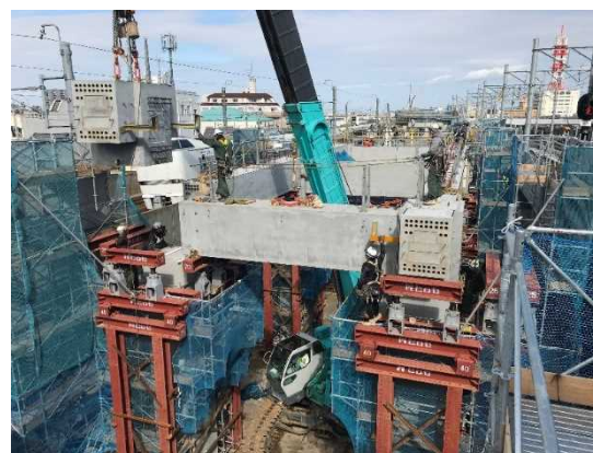
プレキャスト部材組み立て状況
