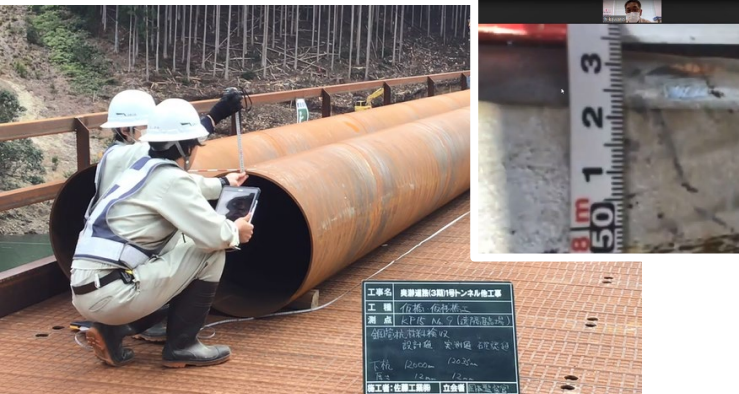
現場での受注者による材料検収状況
