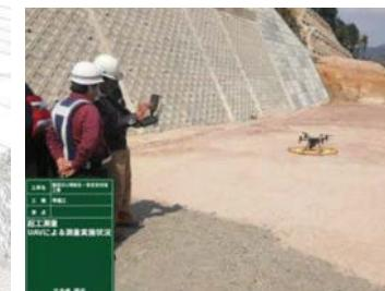
UAVによる3次元起工測量
