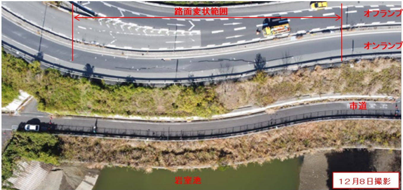
補強土壁の変状
