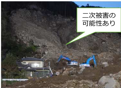
土砂崩落地による災害復旧作業
