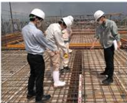
〈従来〉マーキング、メジャーの設置
