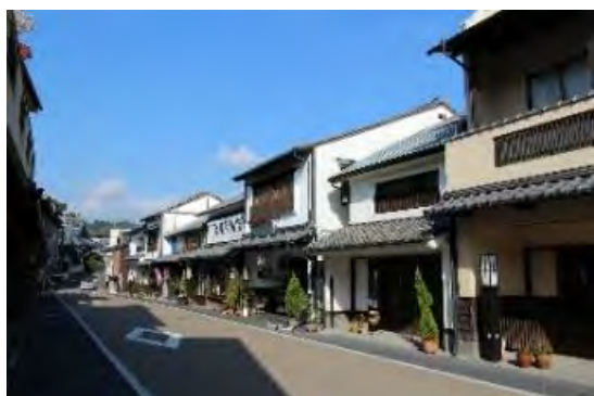
電線類無電柱化を実施した通り
