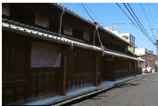
県指定有形文化財 伊藤家住宅
