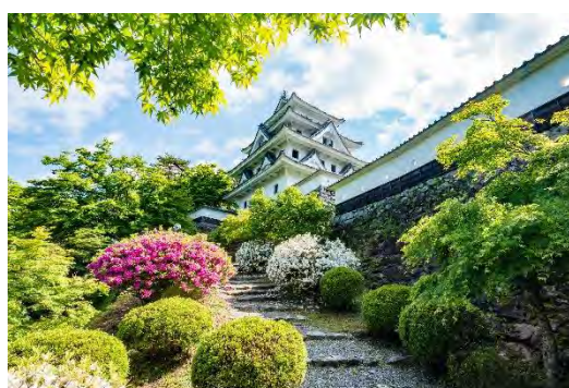
耐震補強工事を終えた郡上八幡城
