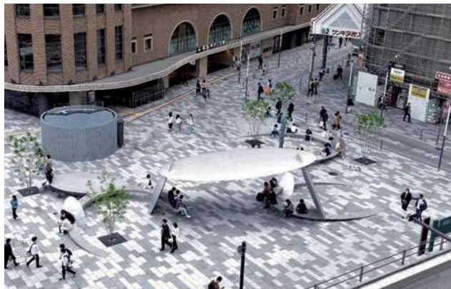
「えき≈まち空間」の象徴となるサンキタ広場。駅敷地、広場、街路は石畳み舗装を段差なく連続させて一体的に整備。
