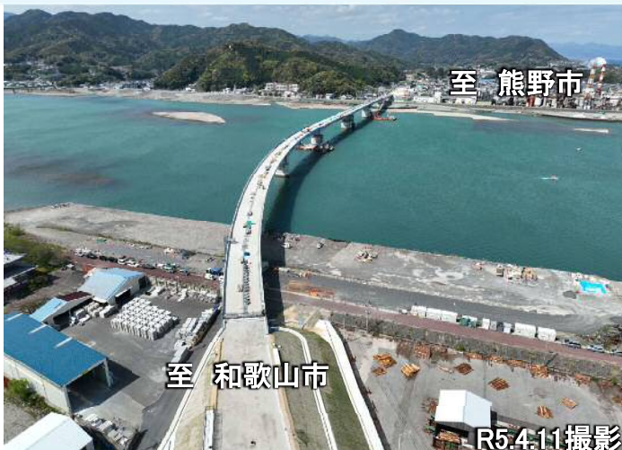
写真① 熊野川河口大橋が連結し、壁高欄や中央分離帯を施工中
