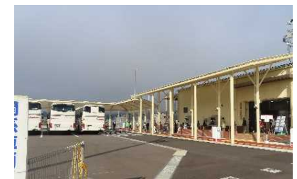
受入環境改善に向けた施設整備状況 (屋根付通路の整備)
