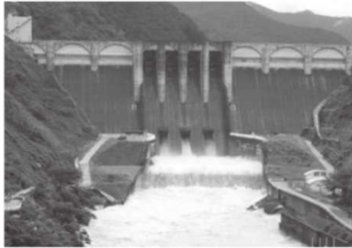
防災操作を実施する大滝ダム
