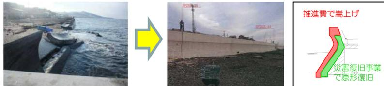
対策例：被災した護岸を災害復旧事業による原形復旧にあわせて、推進費により高上げを実施。
