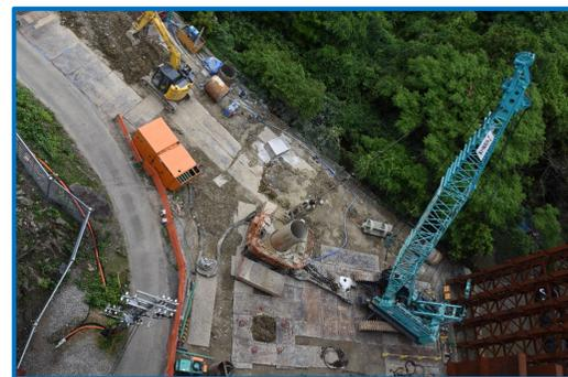
硬質岩によりビットが損耗し掘削難航
