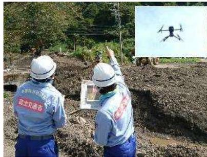
R4ドローンによる砂防被災箇所の調査の事例
