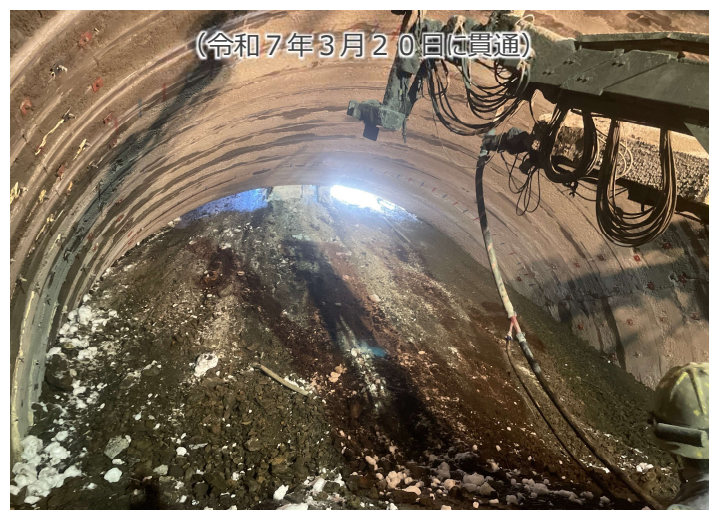
写真2 掘削状況（大谷トンネル）
