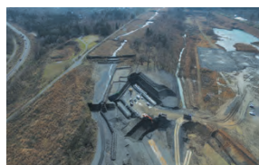
百瀬川天井川切り下げ事業地(高島市)
