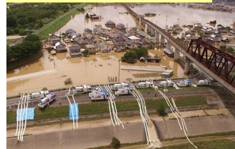
排水ポンプ車による緊急排水
