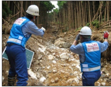
土砂災害調査
