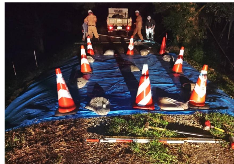
陥没箇所周辺をシート養生
