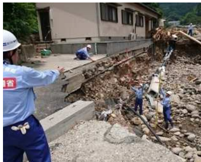
河川被害状況の調査
