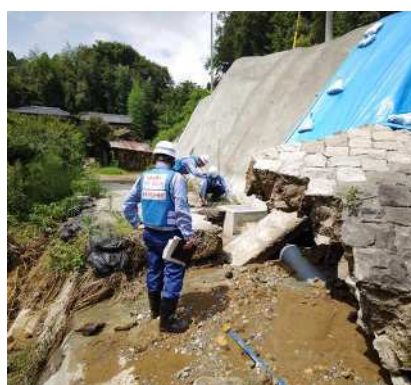
道路法面の被災状況調査 (千葉市)
