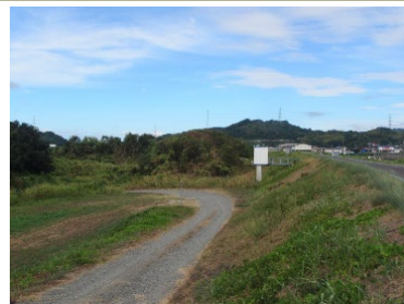
河川敷地内樹木の状況
