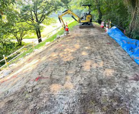
緊急復旧の実施
