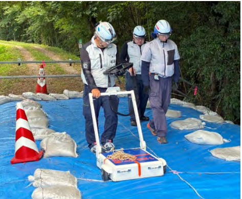
地中レーダーによる空洞調査
