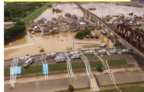
排水ポンプ車による緊急排水
