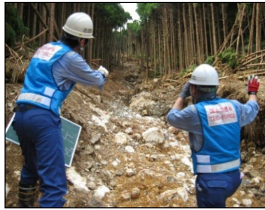
土砂災害調査
