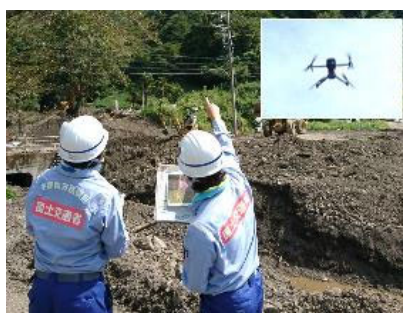
R4ドローンによる砂防被災箇所の調査の事例 (静岡県島田市:中部地整)
