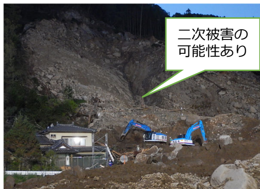
土砂崩落地による災害復旧作業
