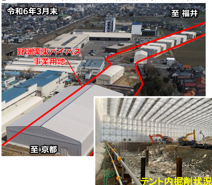
③大型テント内掘削・仮置き場運搬、事業地外搬出
