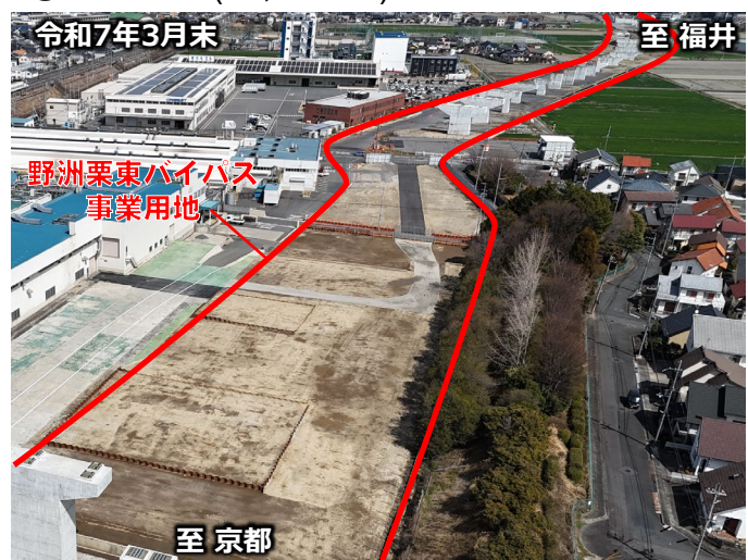
⑥アスベスト(22,400m3)撤去完了、用地基面整正
