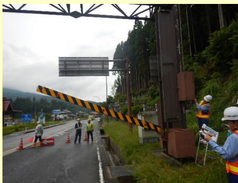
遮断機の操作
