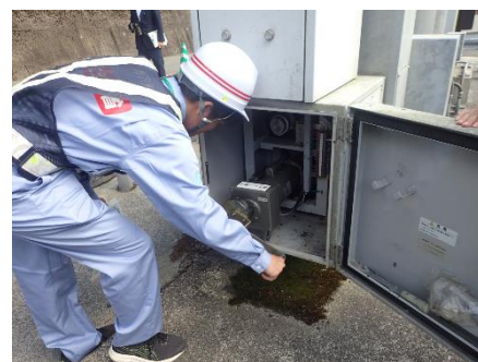
▲停電時は手で遮断機を操作します
