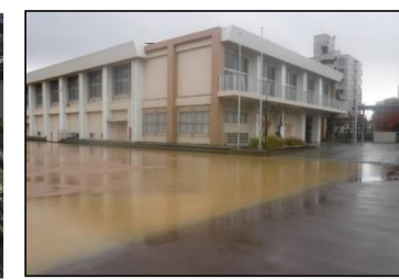
雨水流出抑制施設(校庭貯留)
