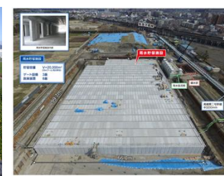
雨水貯留施設(安満遺跡公園)
