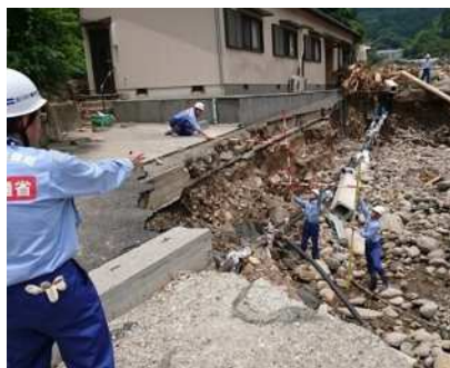
河川被害状況の調査
