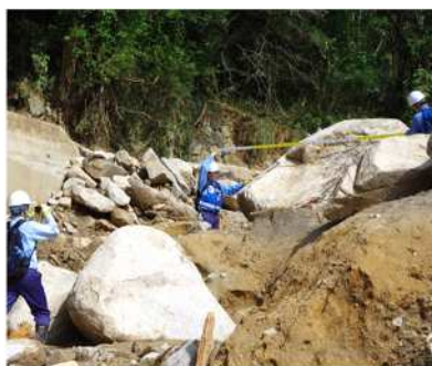
土砂災害被害状況の調査
