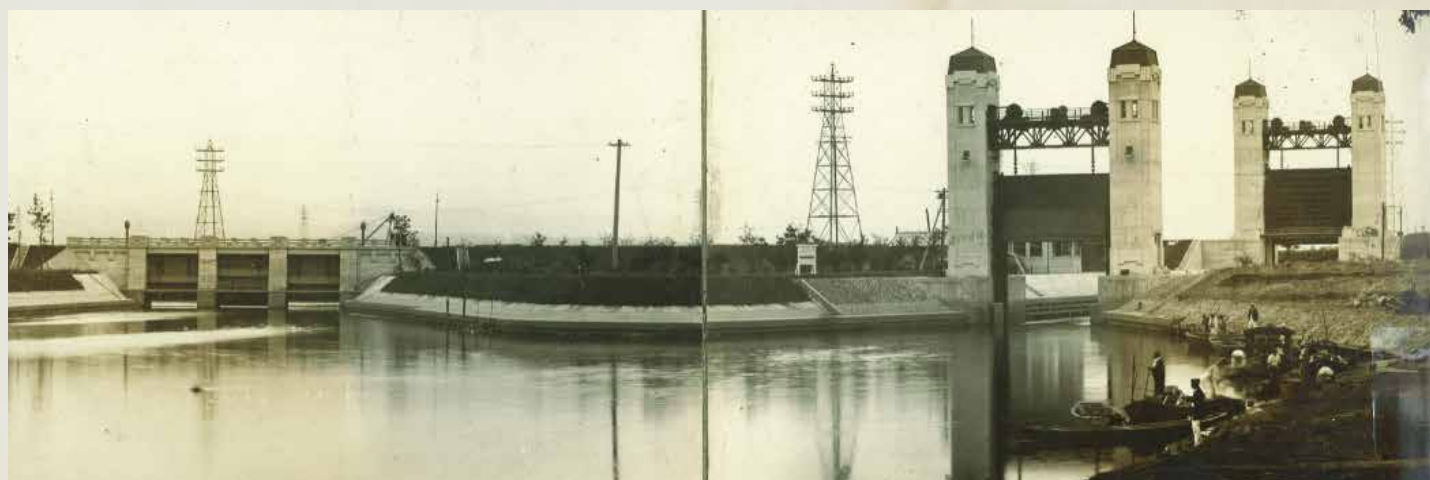
三栖洗堰及三栖閘門 大正7年～昭和8年（1918～1933）
