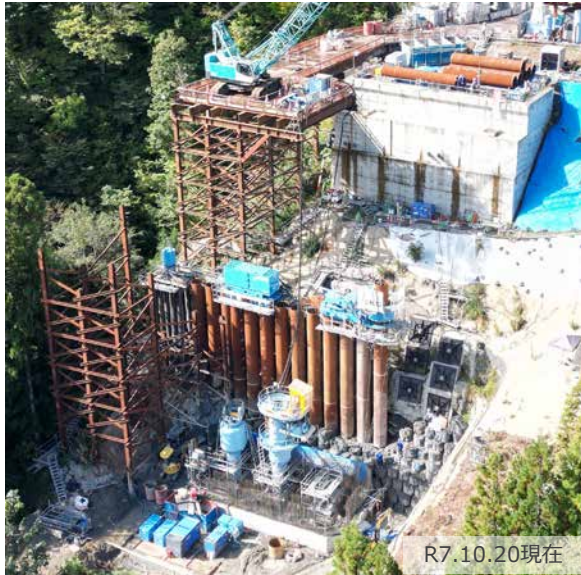
写真3 抑止杭の施工状況
