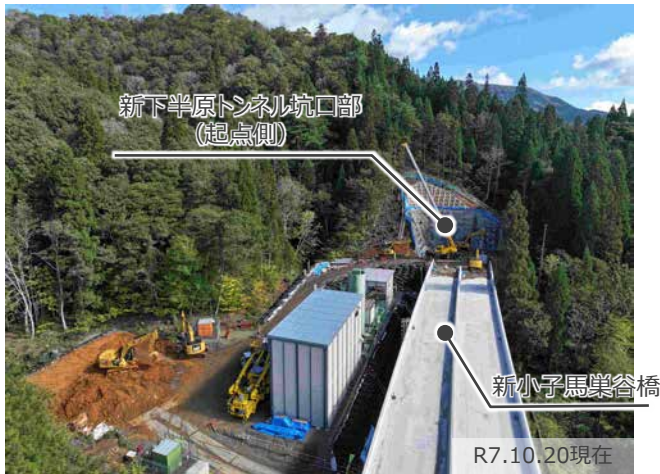
写真2 新下半原トンネル (起点側)
