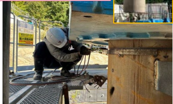
写真5 鋼管杭の切断状況
