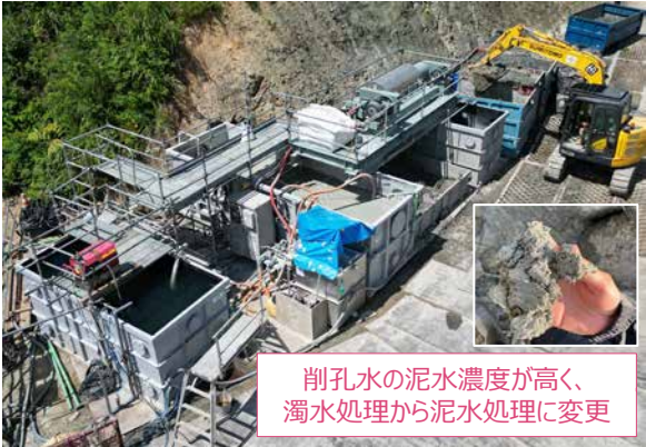
写真4 泥水処理の状況
