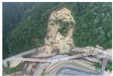
仮設道路の状況
