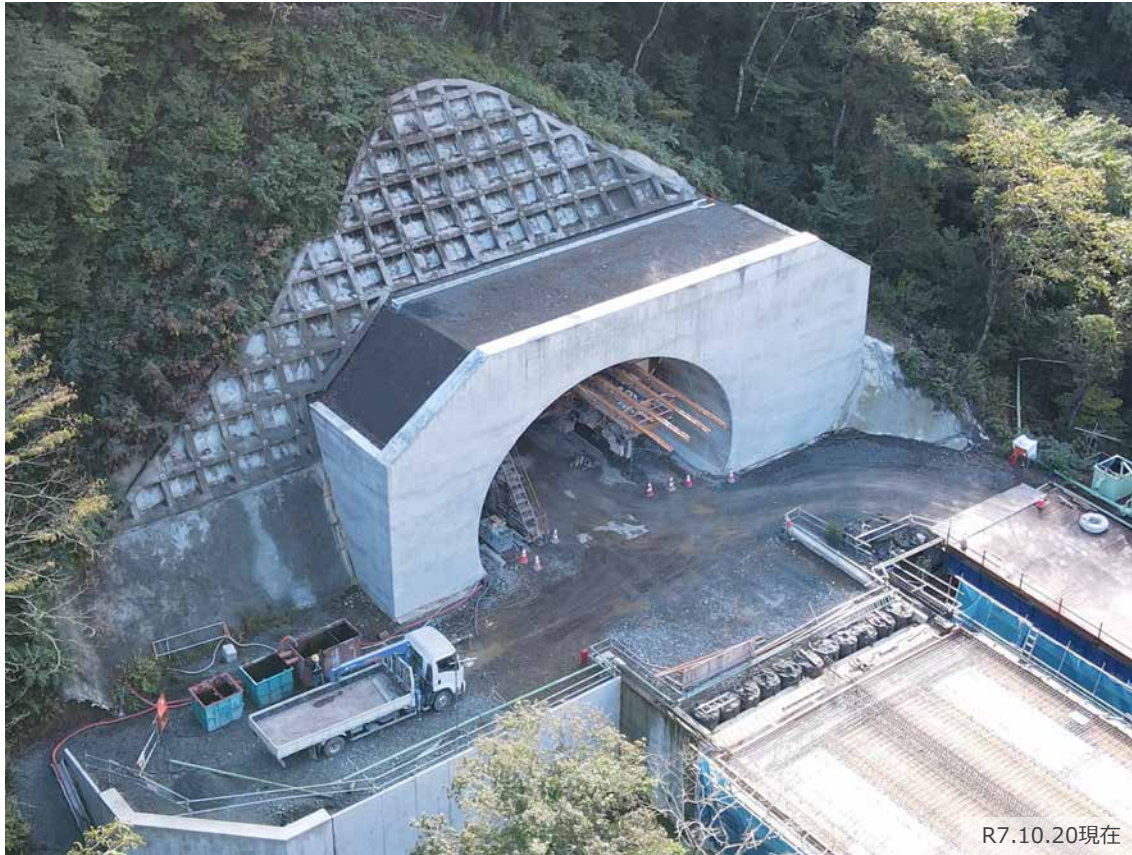
写真1 起点側坑門の状況
