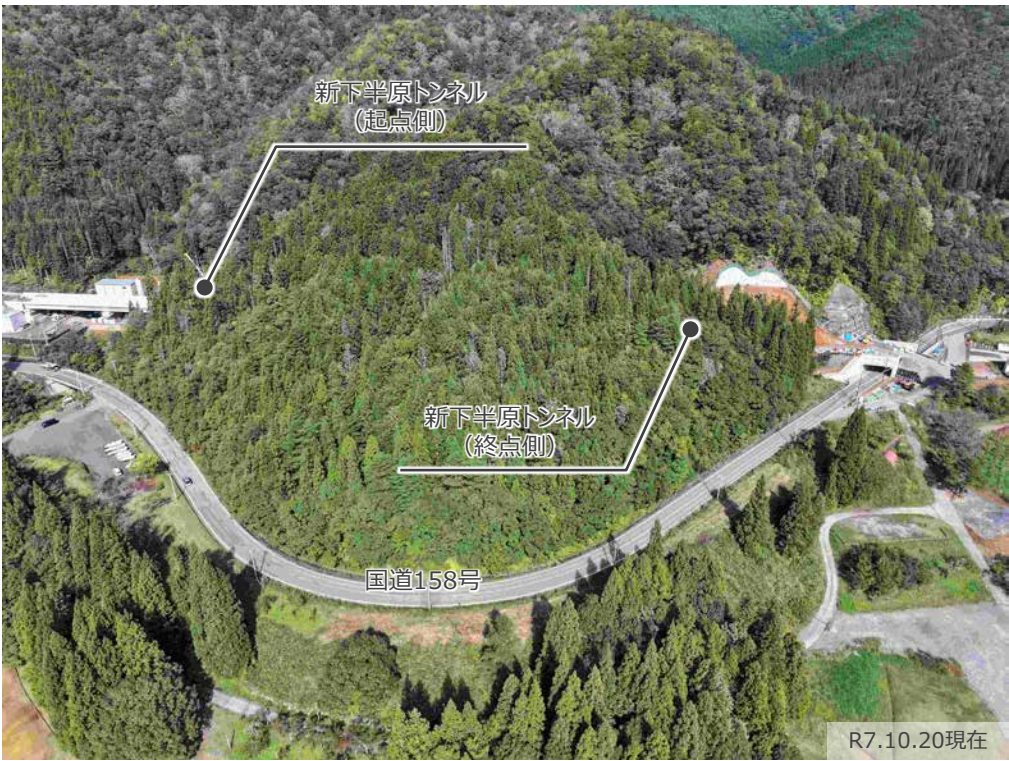
写真1 新下半原トンネル (全体)
