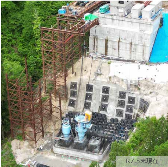
写真2 仮橋撤去・補強後の状況
