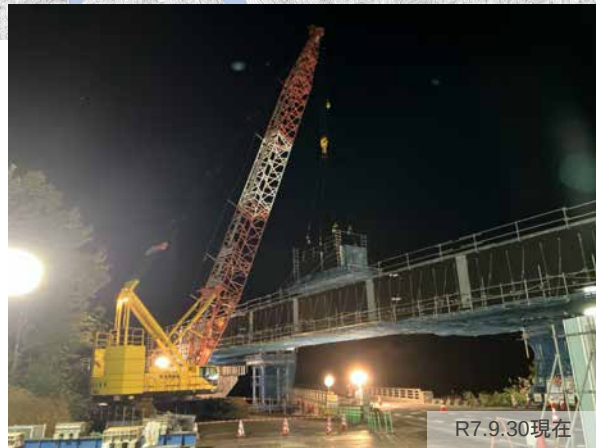
写真2 上部工架設状況
