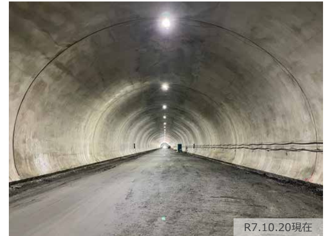
写真2 覆工コンクリートの施工状況
