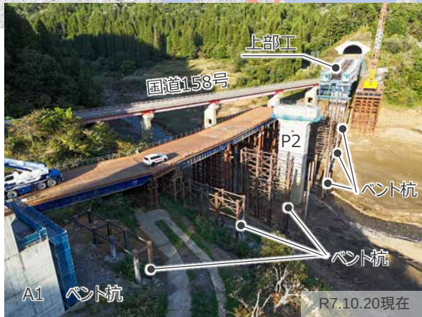
写真1 新林谷橋 (全景)
