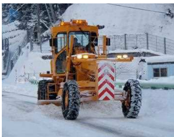
除雪グレーダーによる除雪(前方から)
