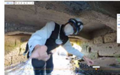
360度カメラと作業状況
